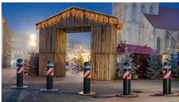
Zdjęcie 2. Tymczasowe mobilne bariery VSB – zabezpieczenie strefy wejściowej jarmarku bożonarodzeniowego (Ratyzbona).
