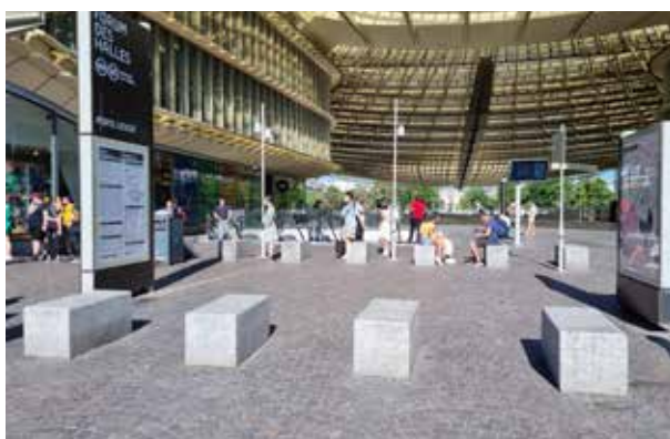
Zdjęcie 7. Bariery betonowe – rozwiązanie o funkcji porządkowej lub potencjalnie ochronnej. Ich kwalifikacja jako barier pojazdowych VSB zależy od certyfikacji i scenariusza zastosowania (Paryż).
