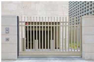
Zdjęcie 11. Ażurowa brama wjazdowa przed zjazdem do garażu w Ambasadzie Republiki Turcji w Berlinie, za bramą są widoczne ruchome słupki zabezpieczające.
