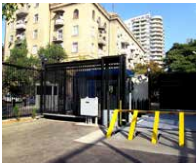
Zdjęcie 8. Zapora drogową typu wznoszącego się klina przed bramą wjazdową na teren Ambasady Stanów Zjednoczonych w Baku.
