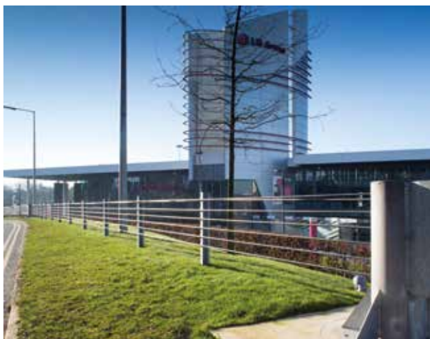
Zdjęcie 11. Ogrodzenie linowe Bristorm.
