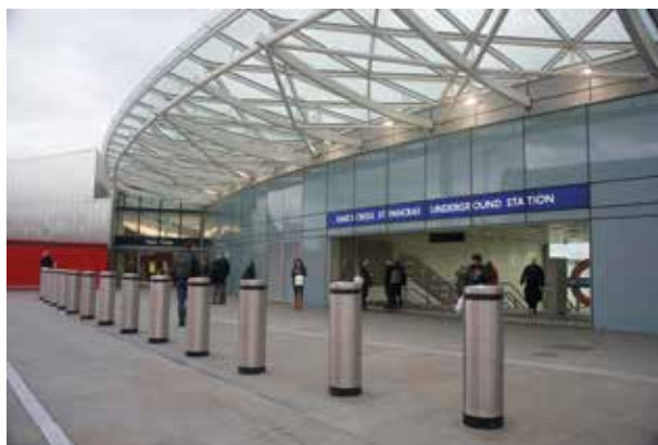
Zdjęcie 5. Bollardy stałe zamontowane na stacji metra w Londynie.
