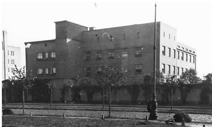
Zdj. 8. Budynek Samodzielnego Referatu Technicznego przy ul. Wawelskiej 9, Ochota (źródło: Archiwum Państwowe w Warszawie)
