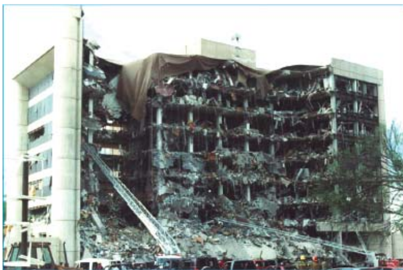
Fot. 1. Alfred P. Murrah Federal Building w Oklahoma City zniszczony w 1995 r. przez atak bombowy.
